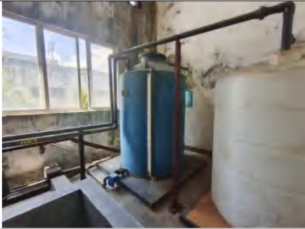
纯水制备站盐酸储罐
