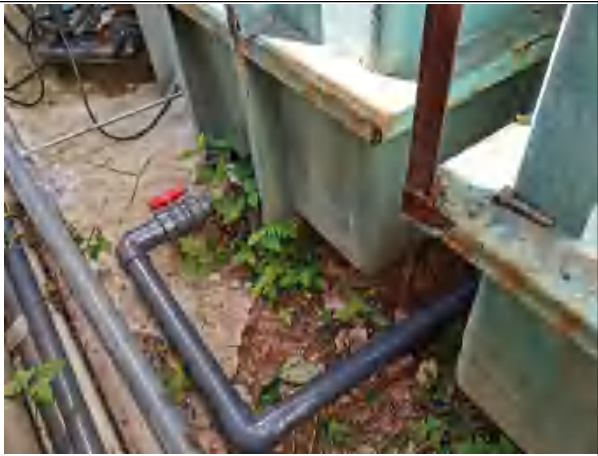
污水处理站应急池的连通管道
