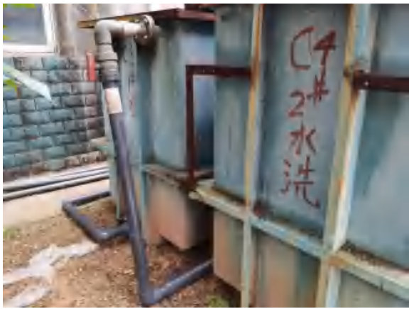
污水处理站应急池的接入管道
