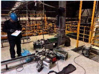
图 4 1#立式喷涂生产线固化炉
