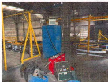
图 20 2#立式喷涂固化排气筒
