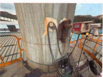
图 18 熔铸 5、6 炉外废气排气筒
