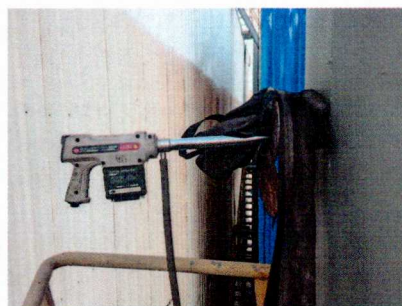
图 2 熔铸 3#除碱工序排气筒
