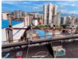
图 21 洗模中心 1#碱雾排气筒
