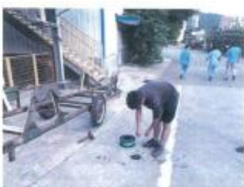
图 20 ☆1 地下水监测井
