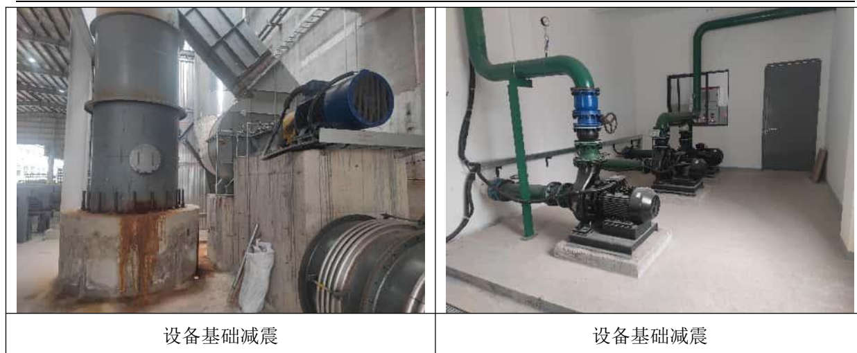
图 4.1-3 设备基础减震照片
