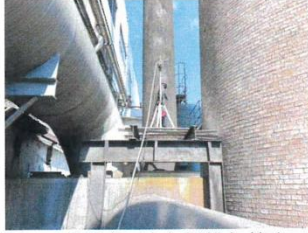
图 11 炒渣机+冷灰桶排气筒出口
